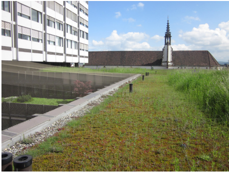
Viherkatto sairaalan katolla Baselissa, Sveitsissä. Kasvualustan paksuuden vaihtelu mahdollistaa monimuotoisen kasvillisuuden.
